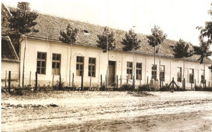
Az Érszekcsanádi Általános Iskola Deák utcai épülete 1960 körül.
